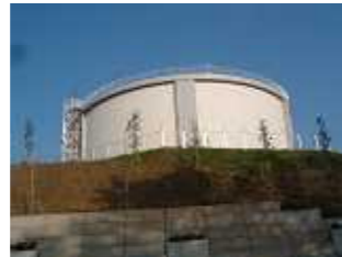
上水道貯水池(出雲市)
