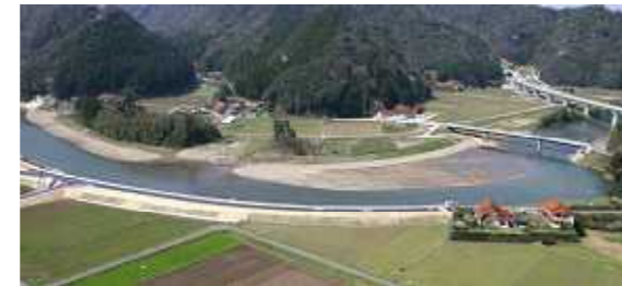
河川改修(神戸川災害復旧)
